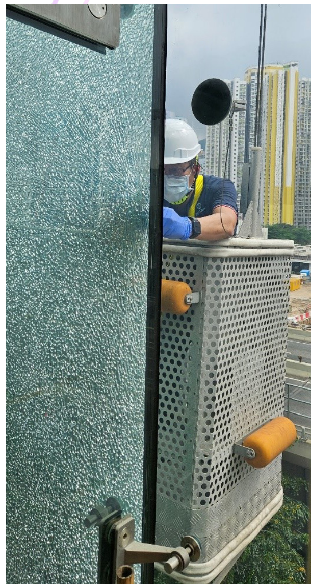
在刑事损坏现场检查破碎的玻璃幕墙。
